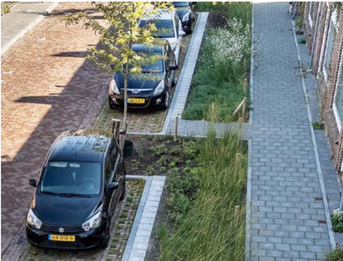
Waterinfiltratie in plant- en parkeervakken
